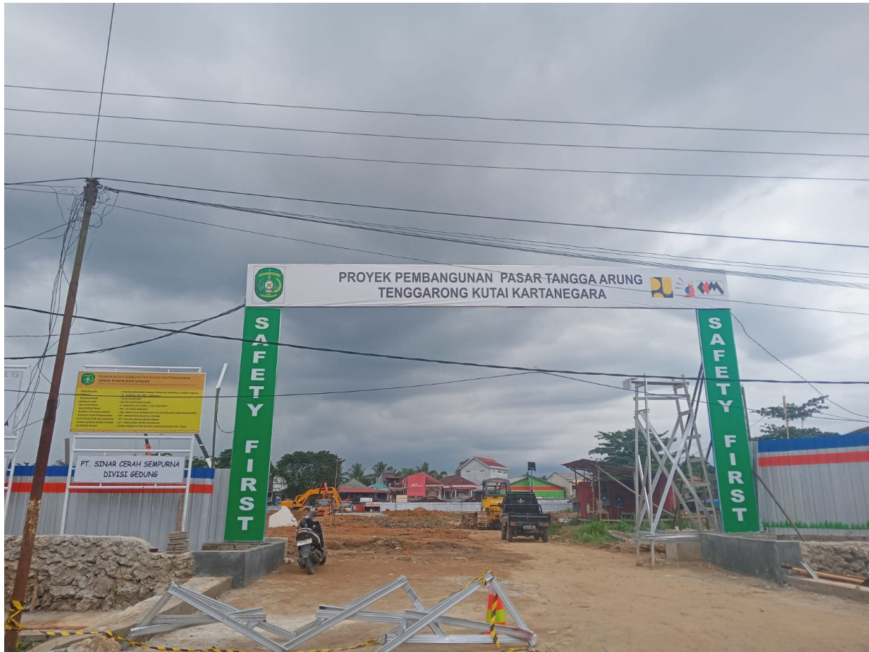
Proses Pembangunan Pasar Tangga Arung (Ady/Radar Kukar)
